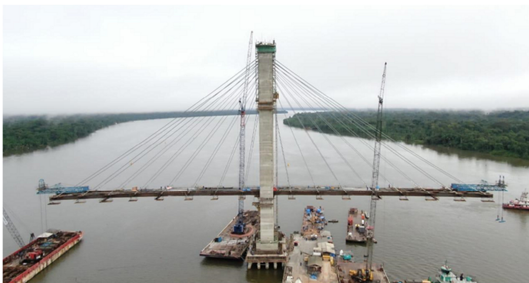
Figura 1 – Fase de execução da ponte do Moju.
