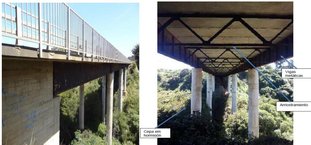
**Figura 6: Puente seminario Vista lateral y vista inferior con detalle de elementos**
