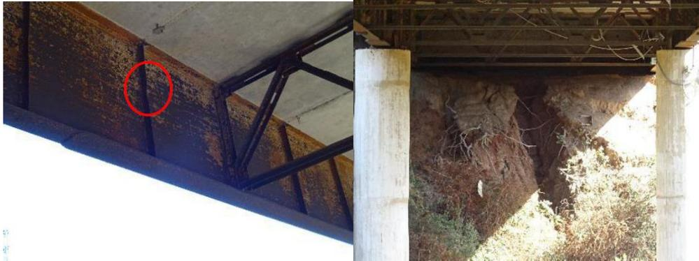
**Figura 8: Daño en estribo y viga metálica**
