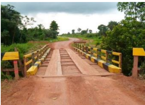
Figura 12 – Exemplo de Ponte Provisória recém recuperada, 2015 (DNIT, 2019).
