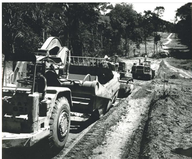
Figura 6 - Construção da BR-230 - Altamira-PA - Outubro de 1971 (BRASIL/SIAN - Sistema de Informação do Arquivo Nacional, 2015)
