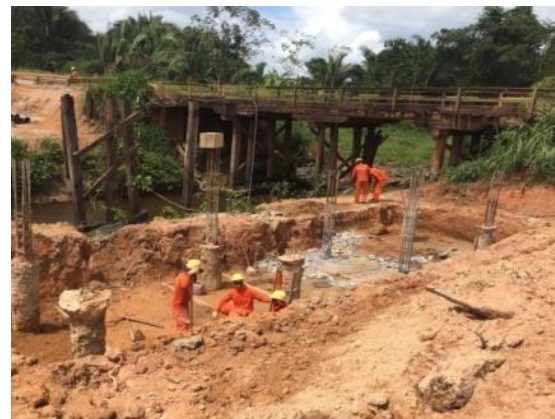
Figura 9 - Exemplo de uma das pontes estudadas, com a construção da ponte definitiva, e ponte provisória de madeira ainda em funcionamento (DNIT, 2019).
