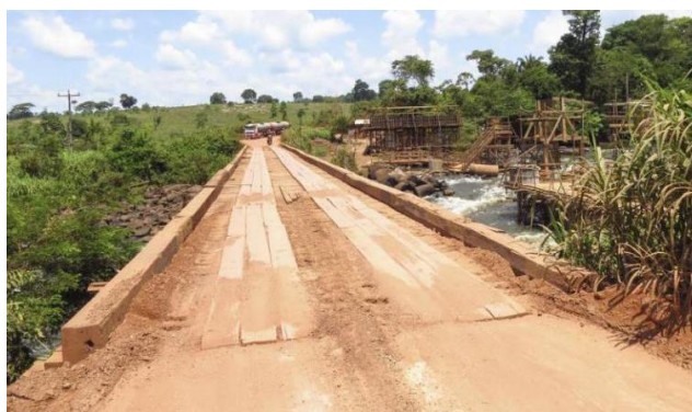
Figura 1 – Ponte sobre o Rio Cupari - Pará - BR-230 (GENTILE, 2019).
