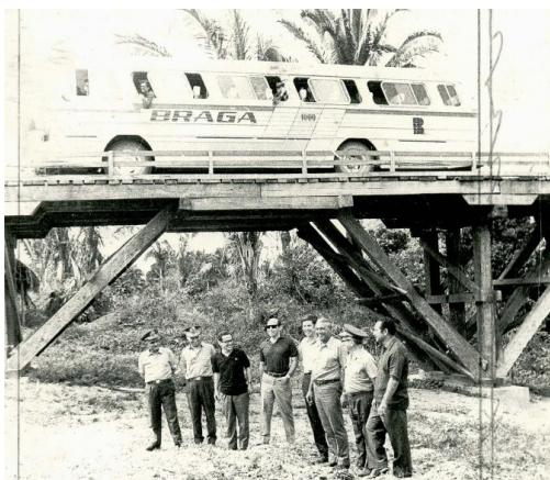
Figura 8 - Ponte provisória de madeira recém construída no ano de 1972 na BR-230 (BRASIL/SIAN - Sistema de Informação do Arquivo Nacional, 2015).
