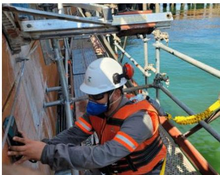
**Figura 2 – Realização do ensaio de detecção magnética de armaduras.**
